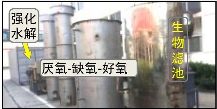
土霉素废水处理全流程中试 (1000L/d)
