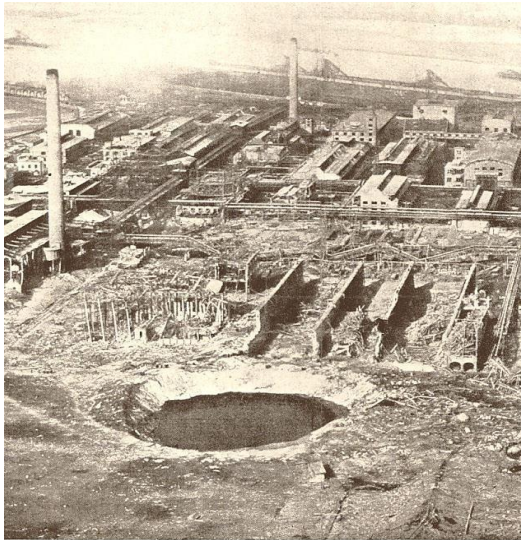
Herd der Explosion und der Umfang der Zerstörung im Oppauer Wert der Baufabrik (B. A. S. F.). Im Vordergrund der durch die Sprengwirkung entfiel Trichter von 125 m Länge, 90 m Breite und 19 m Tiefe, über dem der
