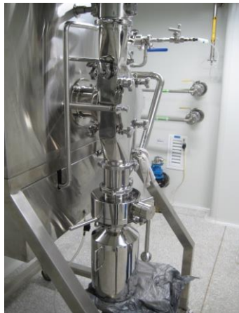
Discharging via SBV出料
